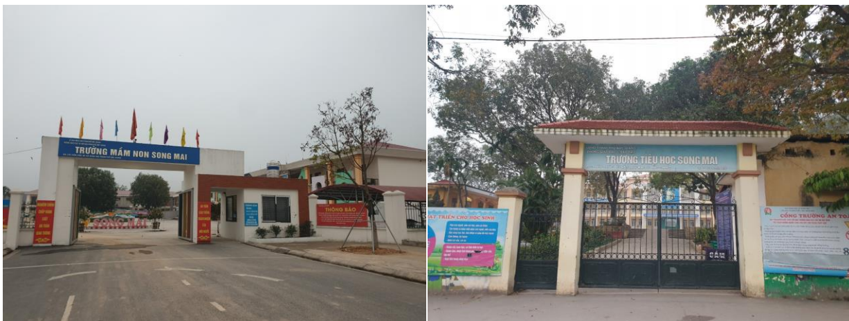
Hình 27. Công trình giáo dục trên địa bàn xã Song Mai
