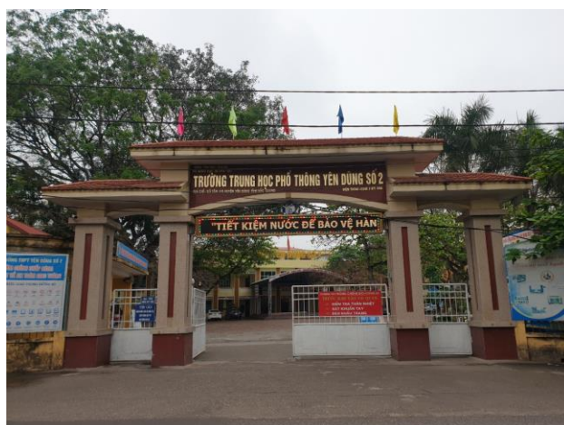
Hình 30. Công trình giáo dục – đào tạo Thị trấn Tân An
