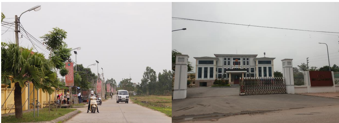
Hình 9. Hệ thống chiếu sáng đường trên địa bàn xã
