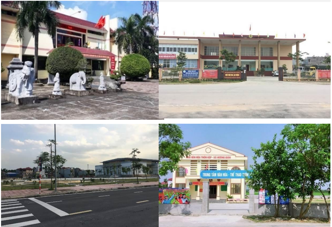
Hình 7. Một số công trình văn hóa trên địa bàn
